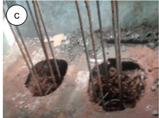
Gambar 10. Perkuatan kestabilan tanah di dekat pondasi a) lubang, b) tulangan, c) lubang dan tulangan
