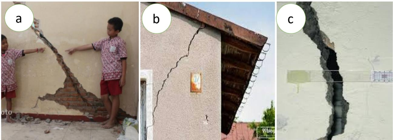
Gambar 4. Kerusakan sedang a) dinding retak berlubang, b) dinding retak 6 mm, c) dinding retak > 6 mm
