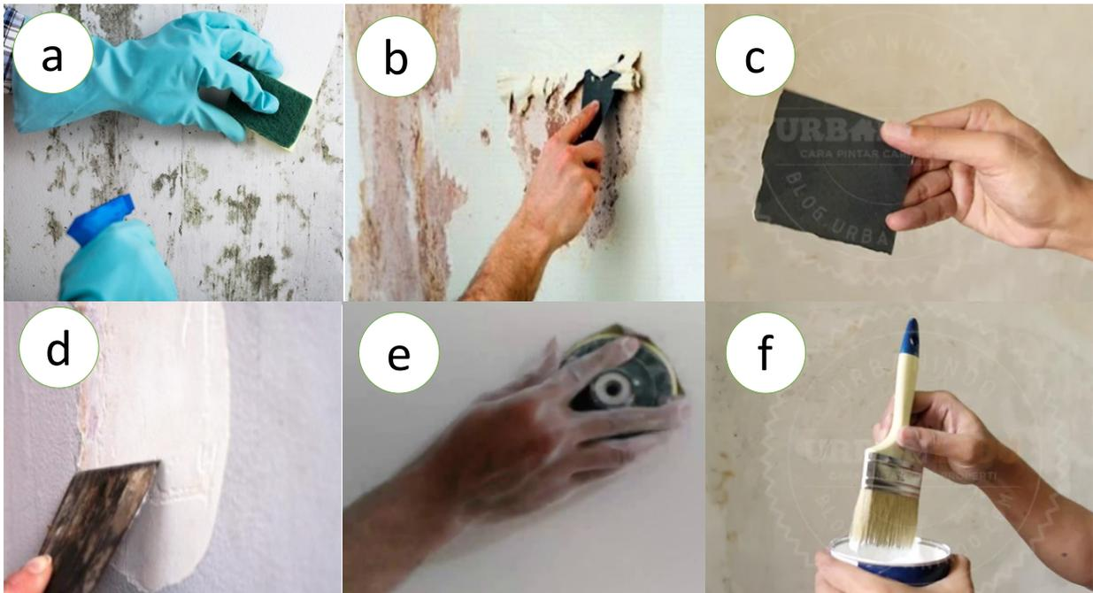
Gambar 7. Perbaikan dinding lembab dan berjamur a) membersihkan dengan air cuka, b) melepas jamur dengan skrap, c) meratakan dengan ampelas kasar, d) meratakan dengan plamur dan e) finishing cat
