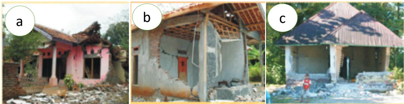
Gambar 5. Kerusakan berat a) struktur rusak dan dinding roboh, b) struktur rusak sebagian dinding roboh, c) Dinding roboh dan Sebagian miring
