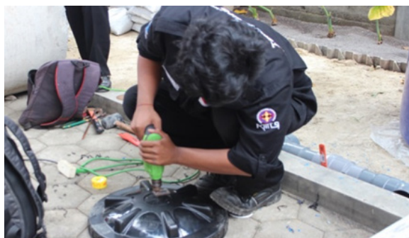
Gambar 9 Proses melubangi tutup tangki
