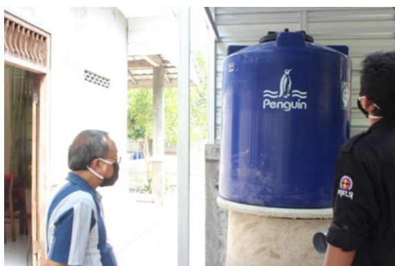
Gambar 10 Tangki yang sudah dinaikkan di buis beton
