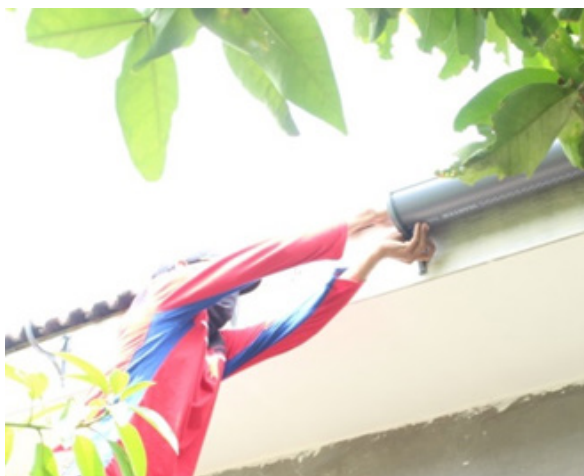
Gambar 6 Pemasangan talang
