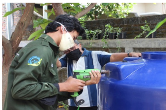
Gambar 8 Proses melubangi tangki
