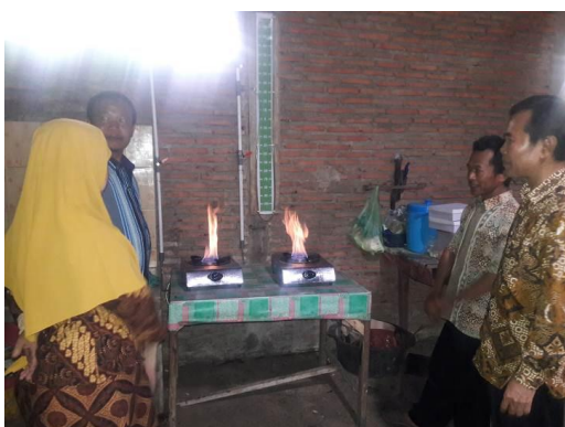
Gambar 10. Instalasi kompor biogas yang telah menyala
