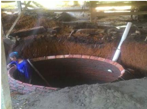
Gambar 4. Pembangunan instalasi biogas
