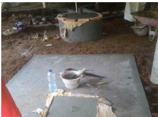
Gambar 8. Pembangunan instalasi biogas yang telah jadi/selesai
