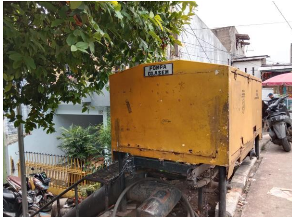
Gambar 1. Pompa banjir (sumber: Bagas dkk, 2021)
