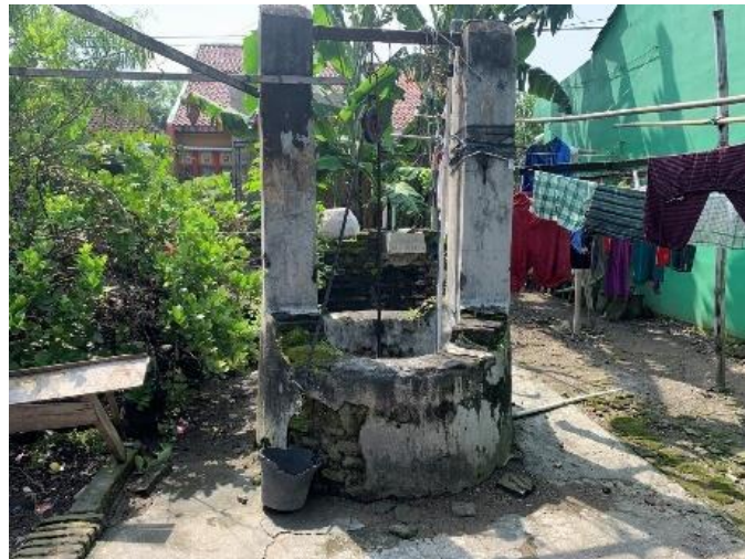
Gambar 7. Kondisi Sumur Gali pada Sumur 3
