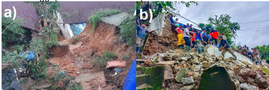
Gambar 4. Longsor yang terjadi Desa Soya (a), Desa Batu Mejah (b)
