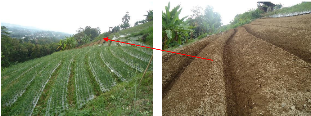
Gambar 3. Pembuatan Teras Saluran Pada Lereng Lebih dari 40%, di Dusun Munggur Desa Girimulyo
