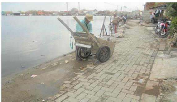
Gambar 4. 11. Pembuatan Talut Sungai di Kecamatan Gayamsari. Sumber: Data Penelitian
