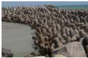
Gambar 5. Penggunaan Pemecah Ombak untuk Mengurangi Dampak Abrasi
