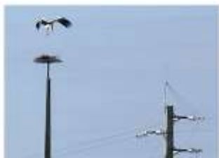
Gambar 9. Tiang dengan pengusir burung dan nesting pole yang diarahkan di sebelahnya Sumber: Prinsen, dkk. 2011
