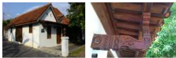
Gambar 10. Kondisi Bangunan Rumah Bapak Sutejo.
