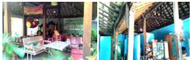
Gambar 8. Kondisi Bangunan Rumah Ibu Nunuk
