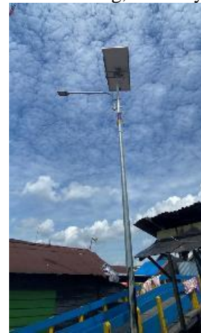
Gambar 16. Penggunaan Penerangan Kawasan dengan Sistem Solar Panel
