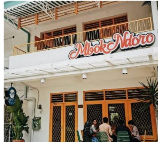
Gambar 13. Kondisi balkon rumah dinas sebelum direnovasi (atas), kondisi balkon shophouse setelah renovasi (bawah)
