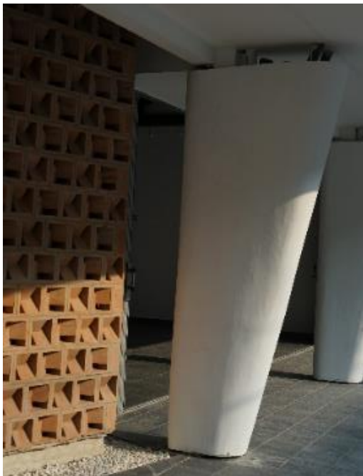
Gambar 9. Kondisi fasad bangunan lobby sebelum renovasi (atas), kolom bangunan setelah diintervensi (bawah)
