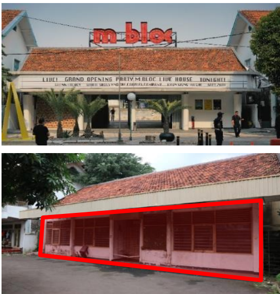
Gambar 8. Kondisi fasad bangunan lobby sebelum renovasi (atas), fasad bangunan lobby setelah renovasi (bawah)
