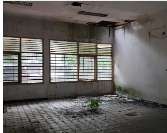
Gambar 10. Area bagian dalam bangunan bekas taman kanak-kanak
