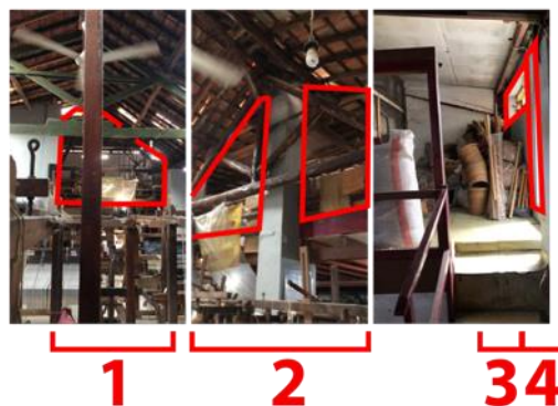
Gambar 11. Kondisi Bukaan Timur Lantai 2
