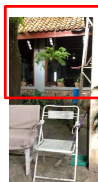
Atap dan bukaan lantai 1
