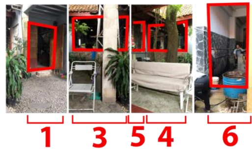
Gambar 7. Kondisi Bukaan Selatan Lantai 1
