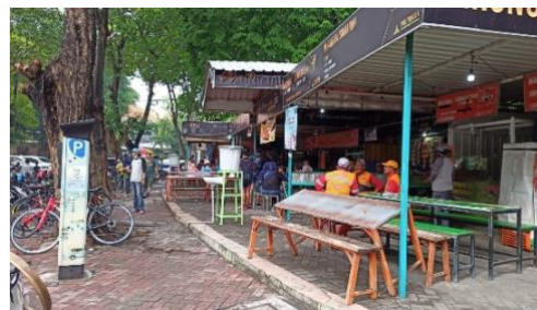
Gambar 4. Kondisi Eksisting Bangunan Sentra Pedagang Kaki Lima di Taman Bungkul
