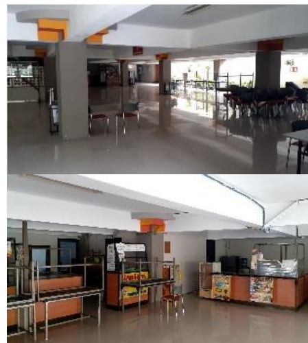
Gambar 7. Kondisi Eksisting Kantin Kampus 4
