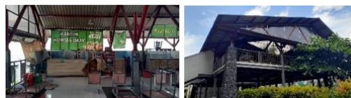
Gambar 4. Kondisi Eksisting Kantin Kampus 3
