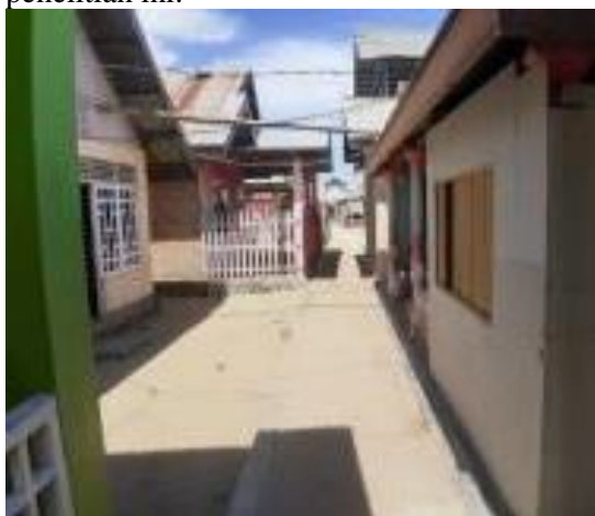
Gambar 12. Jalan Lingkungan tanpa Saluran Drainase
