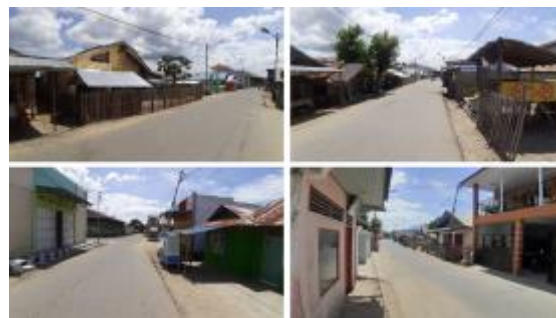
Gambar 7. Kondisi Eksisting Jalan Desa
