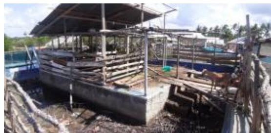
Gambar 13. Septictank Komunal yang dibangun di Badan Sungai
