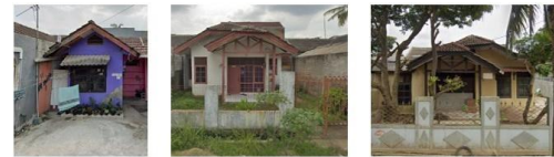
(a) (b) (c) Gambar 5. Rumah tipe 27 (a), tipe 36 (b), dan tipe 54 (c) di Perumahan Bumi Ya pemas Indah
