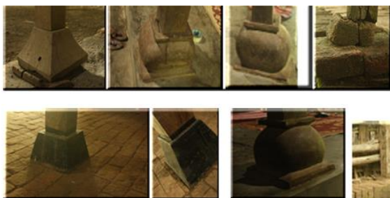
Gambar 7. karya ketukangan pada elemen struktur konstruksi Umpak
