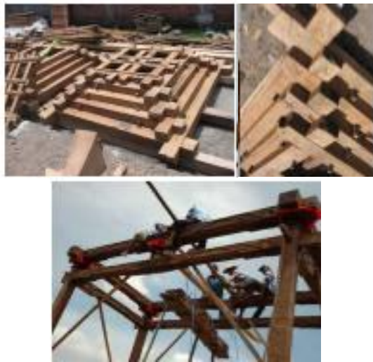
Gambar 2. Elemen konstruksi semua dikerjakan dengan ketukangan tangan dan alat-alat sederhana Sumber : Hardiyati, 2015
