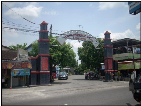
Gambar 4. Kondisi eksisting kawasan pelingkup dengan Pintu Gerbang Kawasan menuju lokasi situs Pesanggrahan Langenharjo
