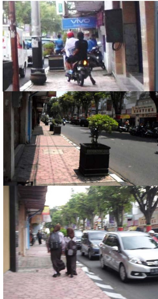
Gambar 6. Kondisi trotoar barat Sumber : Survei, 2018
