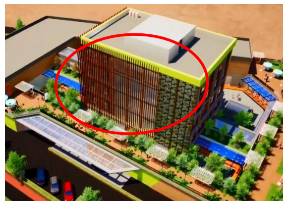
Gambar 10. Sun shading yang terpasang pada bagian selatan dan barat bangunan rawat inap. Terdapat pula vertical garden disampingnya yang berfungsi untuk penghijauan area.
