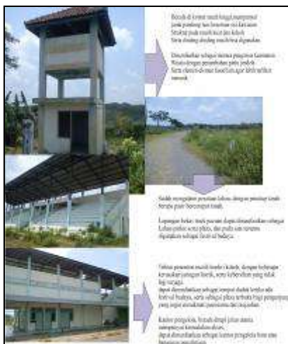
Gambar 9. Pemanfaatan Material Bekas Bangunan Lama
