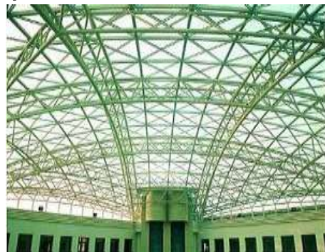
Gambar 8. Sistem Struktur Space Frame (flickr.com)
