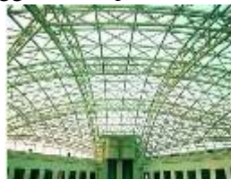
Gambar 9. Sistem Struktur Space Frame (www.spaceframe-bentanglebar.com)
