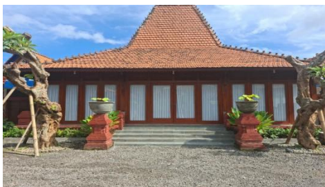
Gambar 3. Tampak Rumah Joglo, Dusun Jendi, Kecamatan Selogiri, Kab. Wonogiri
