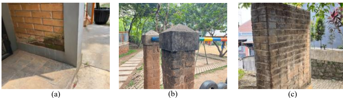
Gambar 9. Pertumbuhan Lumut pada (a) Dinding Bagian Luar Ruang IEPF, (b) Bata pada Dinding Taman Bermain, dan (c) Dinding Sculpture Selamat Datang
