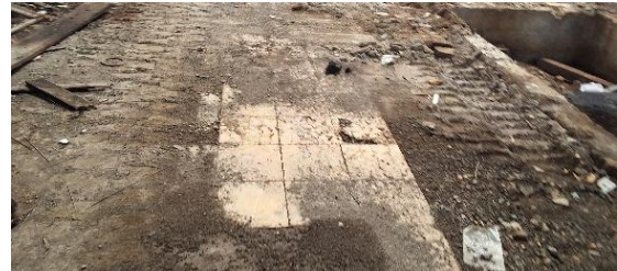
Gambar 8. Lantai Tegel Polos Warna Kuning Keoranyean, Sebagian Permukaan Tertutup Tanah dan Beberapa Tegel Tampak Retak.
