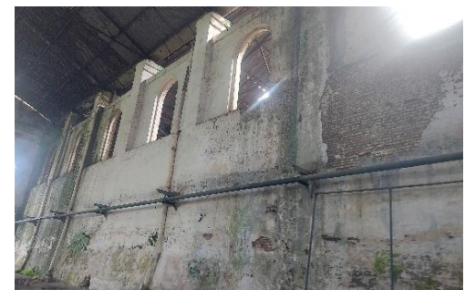
Gambar 4. Dinding Utama Sisi Dalam Pabrik dengan Bukaan Jendela Lengkung, Plester Terkelupas, Bata Ekspos, Noda Lembab, dan Jamur di Bagian Bawah.
