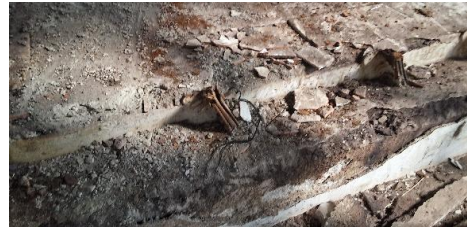
Gambar 7. Lantai Tangga dengan Permukaan Rusak Parah, Terlihat Banyak Bagian yang Terkelupas, Pecah, dan Terdapat Sisa Material Besi Tulangan yang Terekspos.
