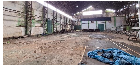
Gambar 9. Lantai Beton Ekspos di Area Packing, Permukaan Rata dengan Garis Putih Penanda Jalur Kerja.
