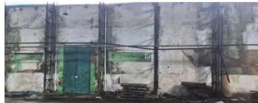
Gambar 3. Permukaan Dinding dengan Pengelupasan Cat, Jamur, dan Plester Rusak. Terdapat Tumpukan Material Bekas di Sekitarnya.
