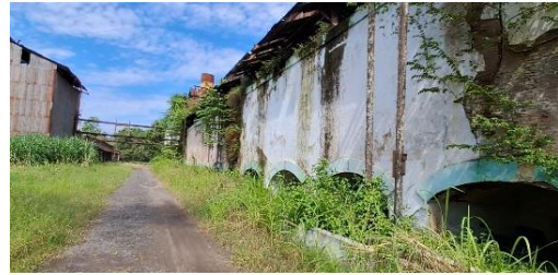
Gambar 2. Tampak Luar Dinding Bata dengan Lengkungan Bawah yang Memperlihatkan Noda Air, Lumut, dan Retakan Vertikal. Vegetasi Liar Tumbuh di Sepanjang Pondasi.
