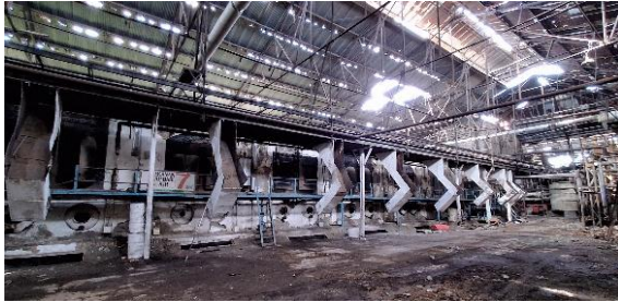
Gambar 5. Kondisi Interior Ruang Produksi Menunjukkan Korosi pada Rangka Baja dan Banyaknya Lubang pada Penutup Atap.
