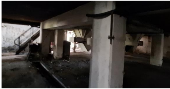
Gambar 1. Struktur Utama Bangunan Pabrik Gula Pangka
