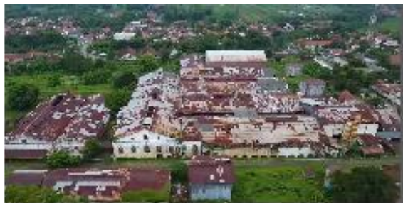
Gambar 6. Foto Udara (Perspektif Mata Burung) Memperlihatkan Area Atap yang Luas dengan Penutup Atap yang Sudah Berkarat dan Berlubang di Banyak Titik.
